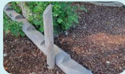
Een paal die steun biedt bij het beklimmen van een balk in de samenspeelplek Hoeven in Halderberge.
