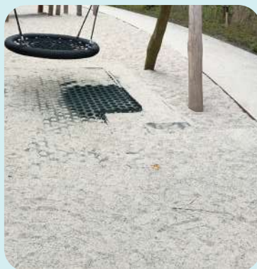
Matten op een ondergrond van zand in de Kruidtuin in Mechelen.
