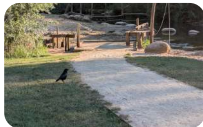
Een halfverhard pad in het provinciedomein in Kessel-Lo. Deze halfverharding bestaat uit dolomiet.
