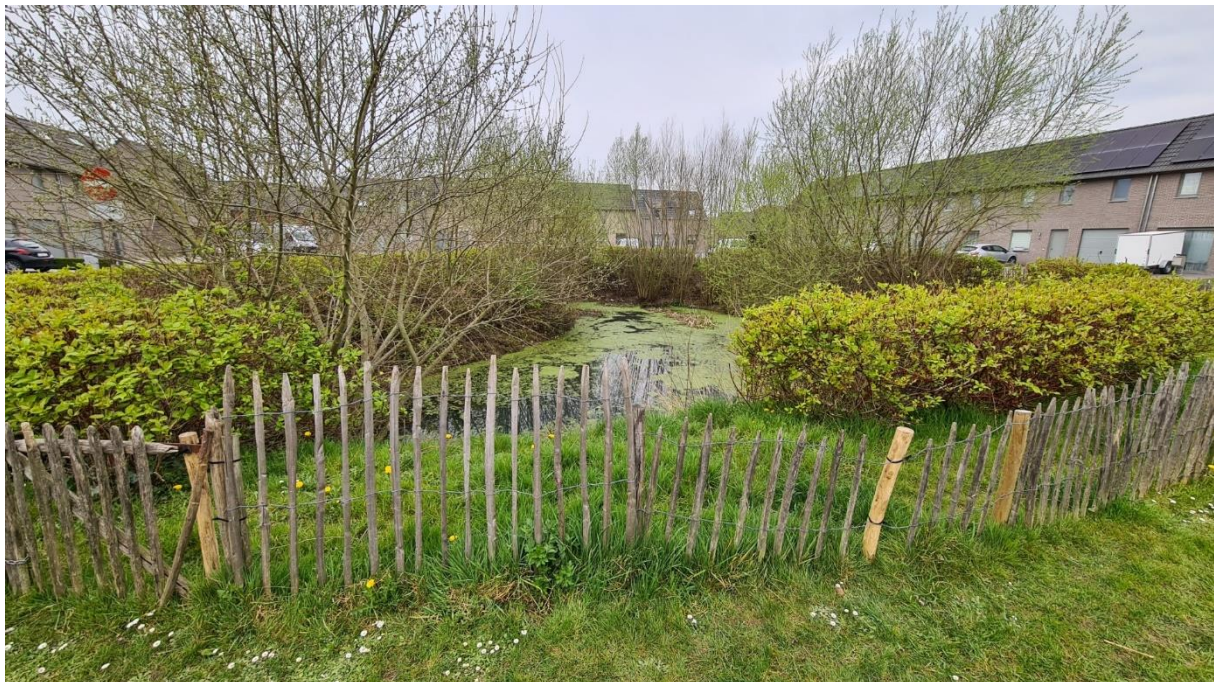
Te diepe wadi's leiden tot hekwerk, waarna de publieke ruimte niet meer bruikbaar is voor andere functies.
